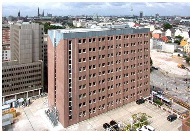
Der 1957 erbaute Büroturm erhielt im Jahr 1967 eine Aufstockung um das 10.OG. 1990 erfolgte die Erneuerung der Natursteinfassade.
