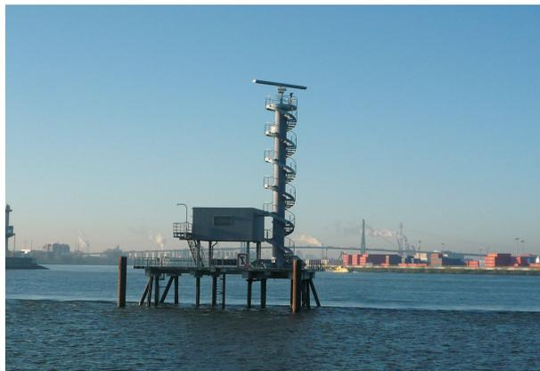
Der 1959 auf einer aufgeständerten Stahlbetonplattform am Fischereihafen Altona errichtete Gittermast-Radarturm wurde rückgebaut und durch einen neuen Radarturm ersetzt.
