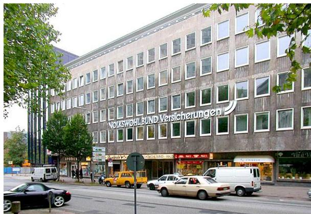
Das untersuchte Bürogebäude wurde 1958/1959 in Stahlbeton-Skelet-Bauweise mit fünf Obergeschossen, einem Staffelgeschoss und zwei Untergeschossen errichtet. Das Dach ist als Flachdach mit innenliegender Entwässerung ausgeführt.
