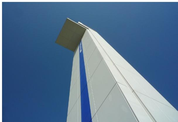
Am Flughafen Berlin-Brandenburg International - BBI wurden für die DFS - Deutsche Flugsicherung zwei neue Radartürme errichtet. Im südlichen Flughafenbereich ein Turm mit einer Bodenradaranlage und einer Höhe von 43 m; im nördlichen Bereich ein Turm mit einer Höhe von 65 m zur Aufnahme einer Anflug-Radaranlage und einer zusätzlichen Bodenradaranlage.
