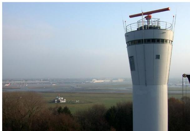
Der Radarturm mit einer Höhe von 45 m zur Unterbringung einer Bodenradaranlage ist im westlichen Teil des Flughafengeländes angeordnet.
